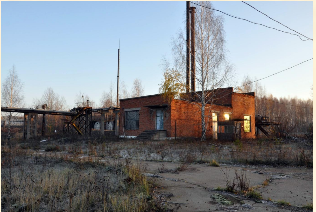
Кирпичное здание склада аммиака С-8
