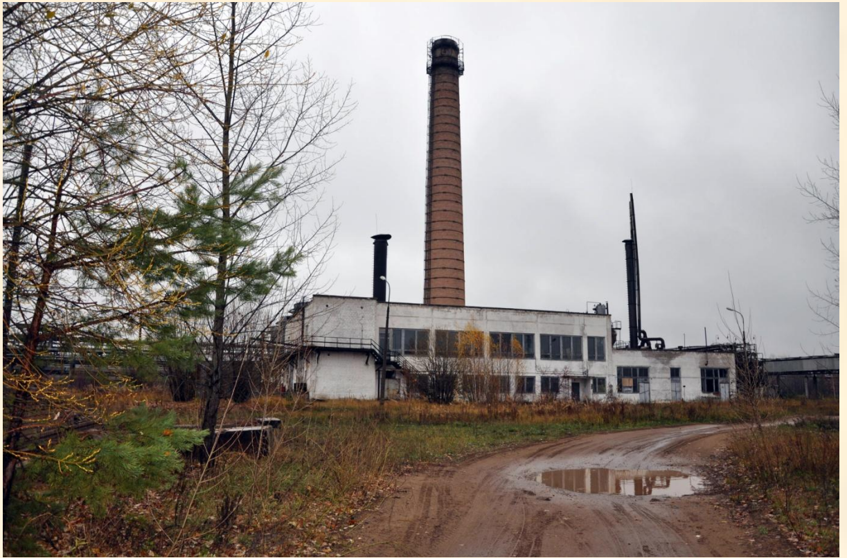
Здание операторной (ИФ-18)
