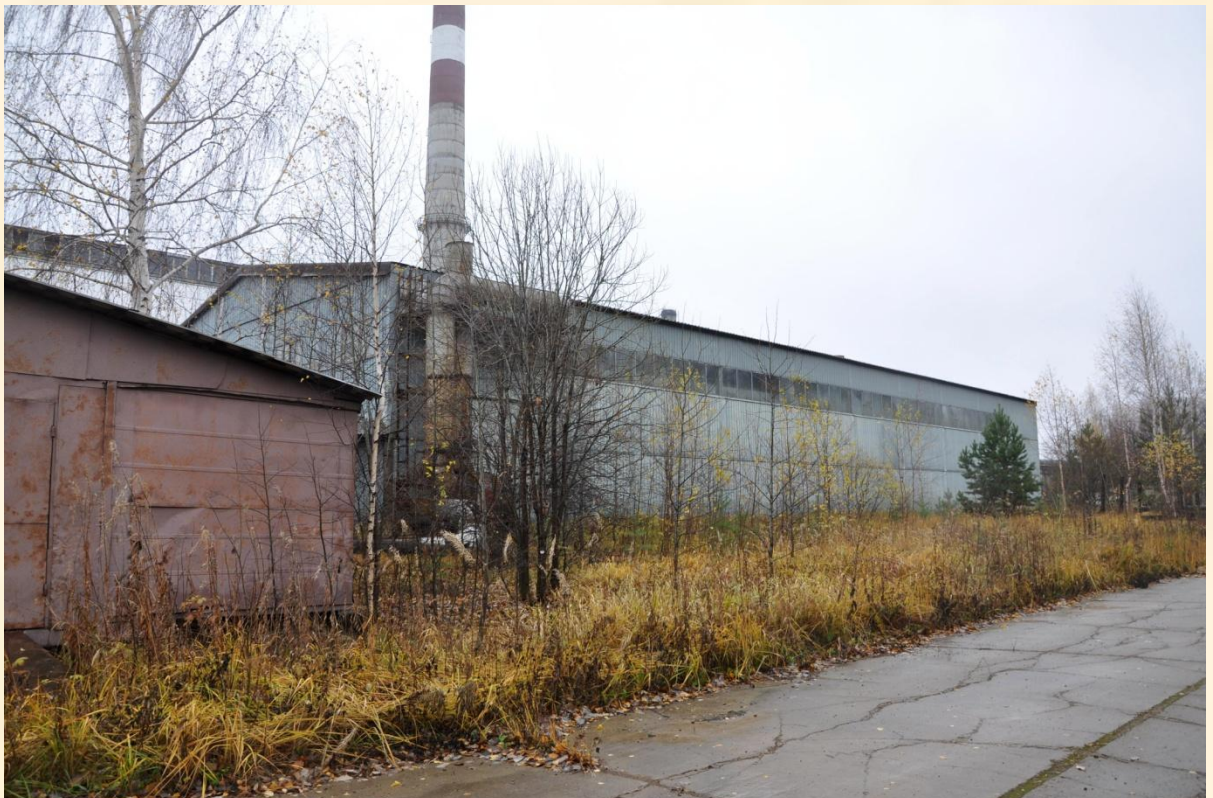
Производственное здание ЦЦР из двойных металлических ребристых панелей
