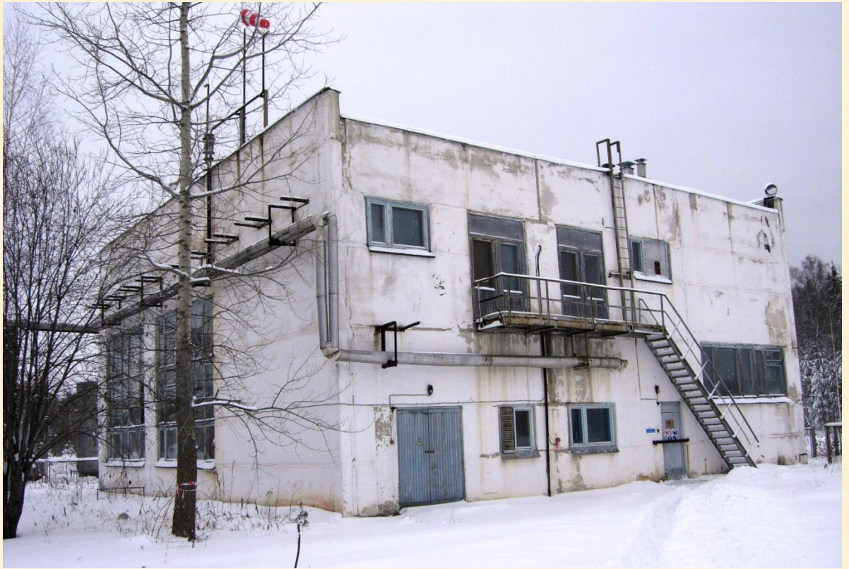
Панельное здание водородно-кислородной станции
