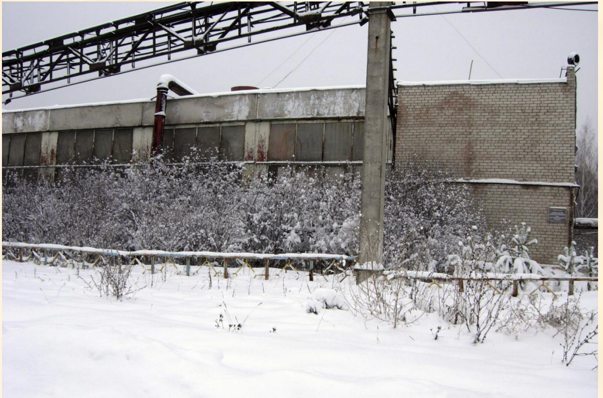
Здание из смешанных конструкций механической мастерской
