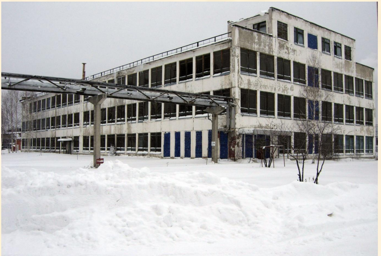
Здание с техническим этажом цеха Р-6
