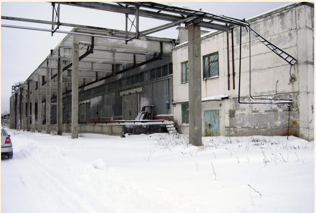
1-2-этажное панельное здание С-6-8 склада сыпучих и изоляционных материалов
