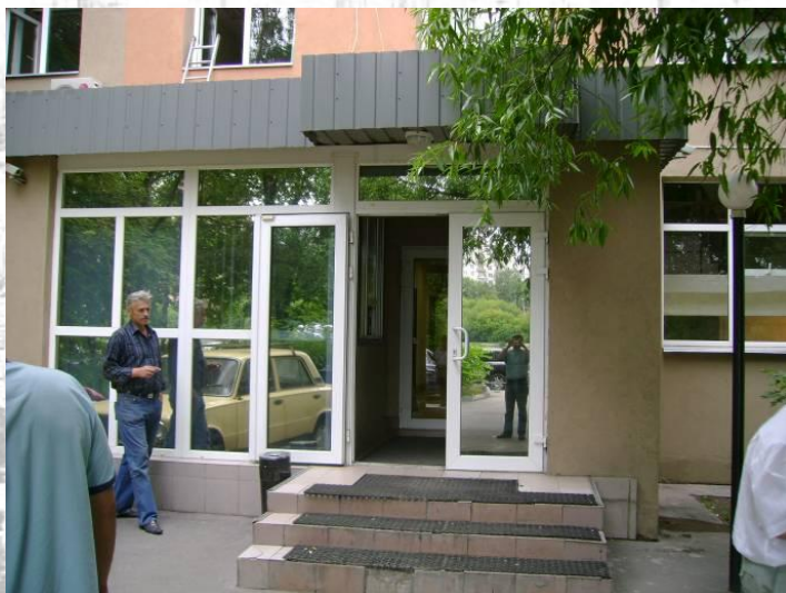
Вход в здание
