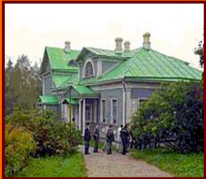
Главный дом усадьбы Шахматово после реконструкции.
