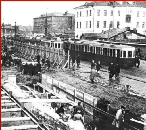
Строительство первой линии метро
