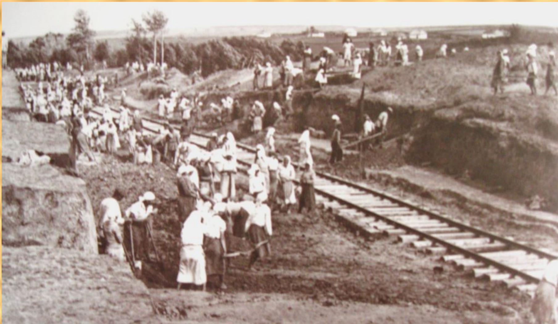
Бригада Старооскольского района на строительстве железной дороги Старый Оскол – Ржава 1943 года
