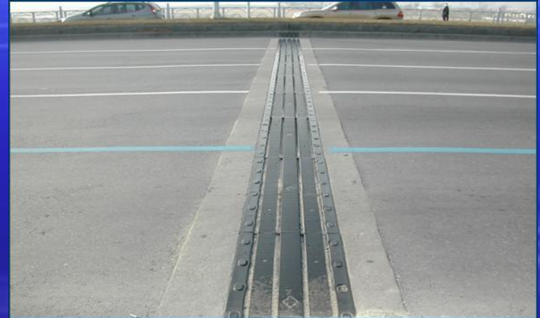
Вид сверху – повреждений не видно:
