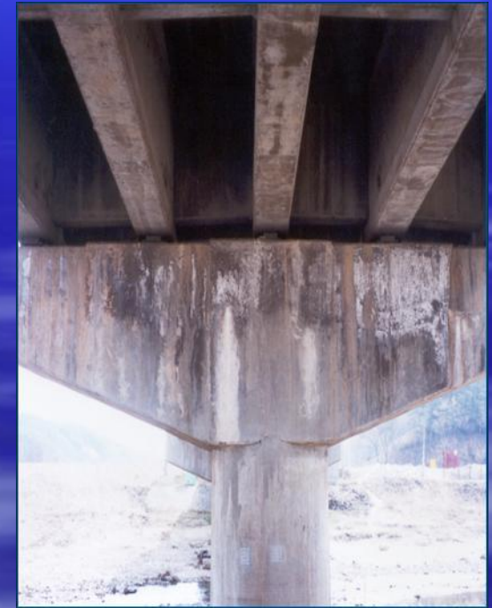
Отслоение бетона
