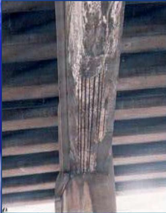
Перегрев бетона
