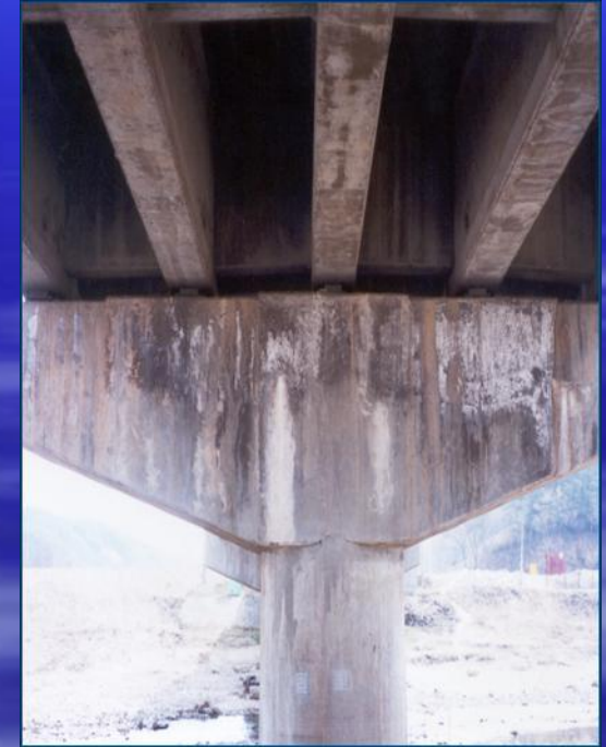
Отслоение бетона
