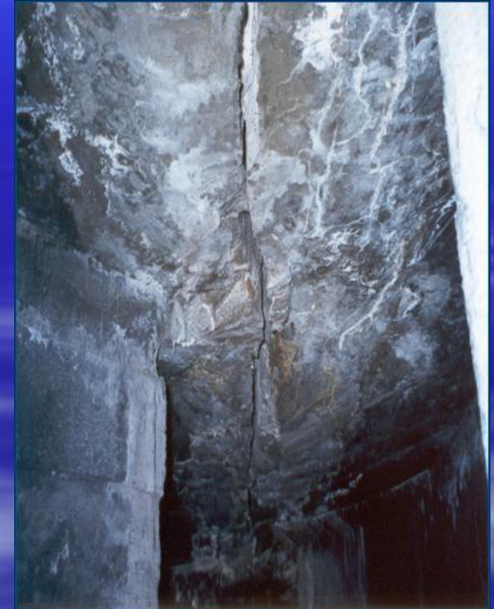
Отслоение бетона
