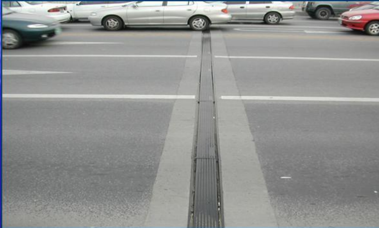
Вид сверху – повреждений не видно:
