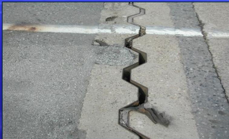
Полное разрушение резиновой мембраны:
