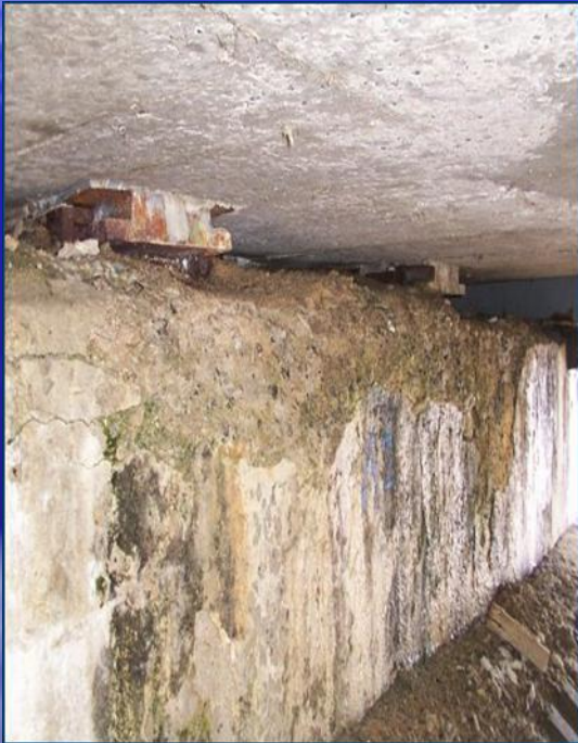
Перегрев бетона
