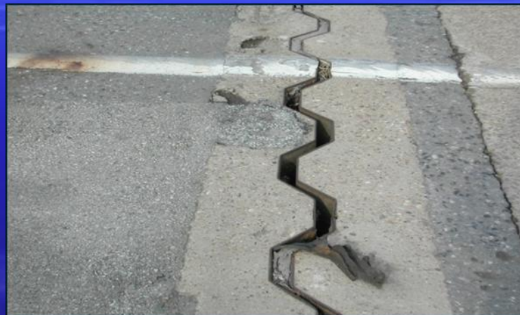
Полное разрушение резиновой мембраны:
