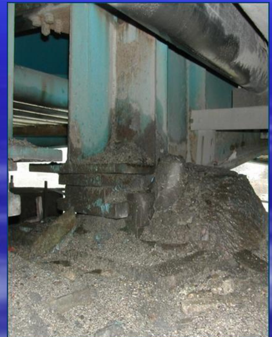
Повреждения пролетной балки
