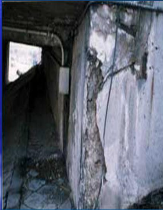
Ускорение коррозии металла
