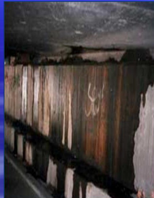
Отслоение бетона
