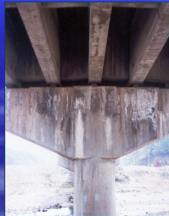
Отслоение бетона
