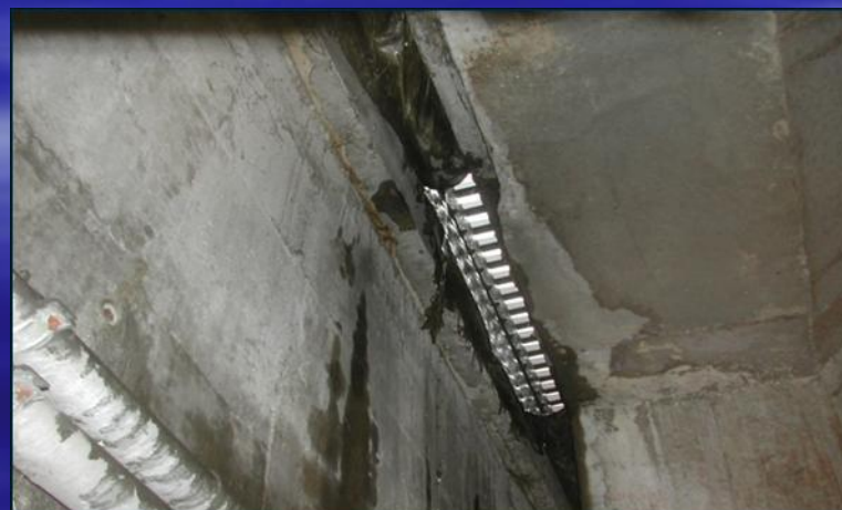
Полное разрушение резиновой мембраны:
