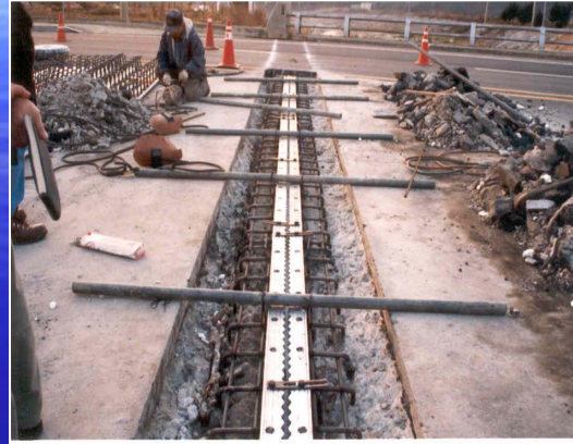
Укладка с поддерживающей системой
