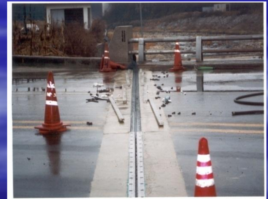
Очистка и установка резиновой мембраны для следующего ряда
