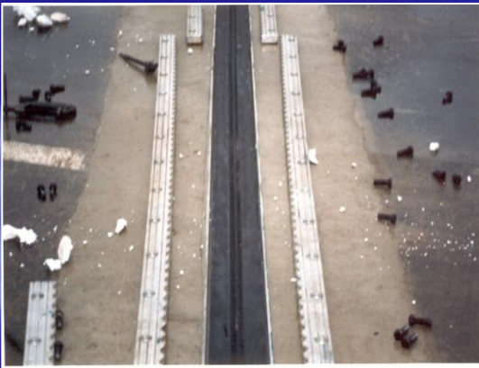
Установка резиновой мембраны
