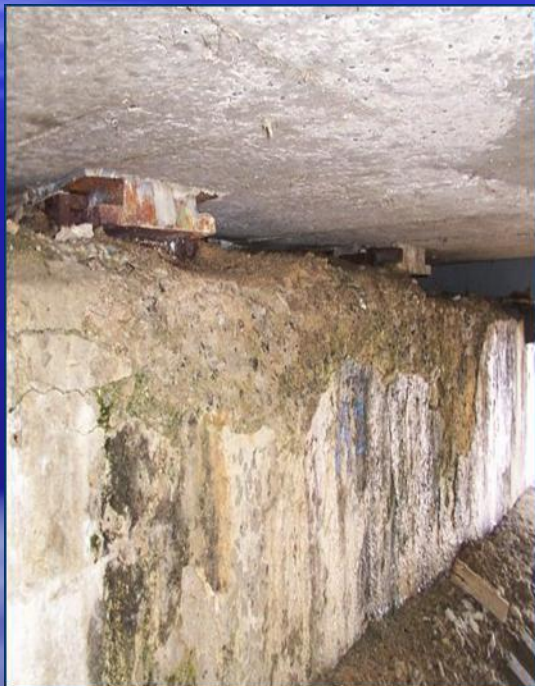
Перегрев бетона
