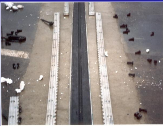
Установка резиновой мембраны
