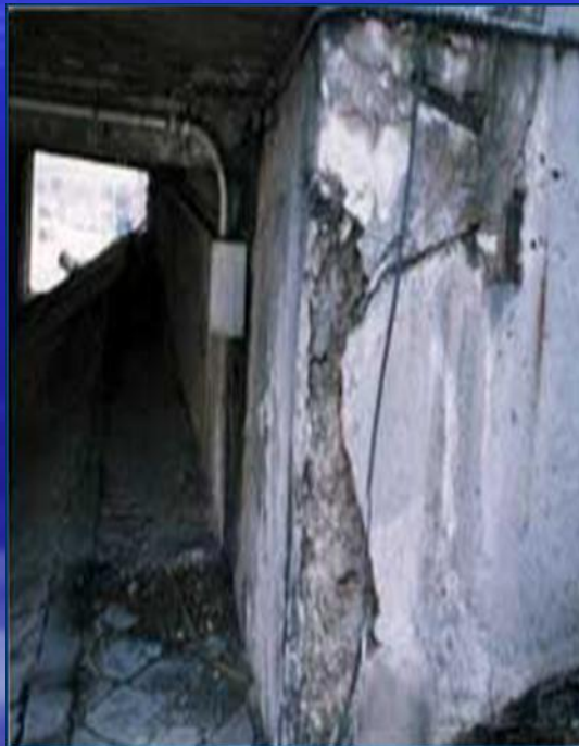
Ускорение коррозии металла
