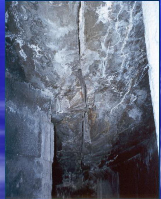
Отслоение бетона
