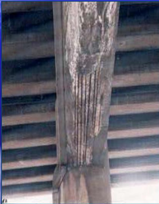
Перегрев бетона
