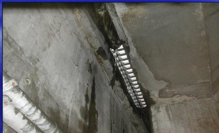
Полное разрушение резиновой мембраны:
