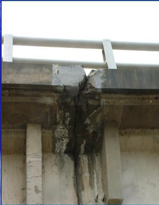
Перегрев полотна
