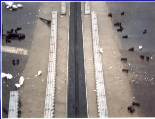
Установка резиновой мембраны
