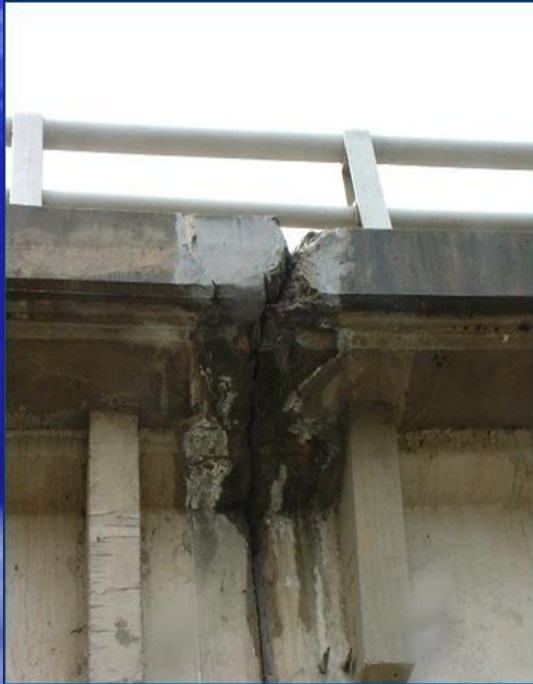
Перегрев полотна
