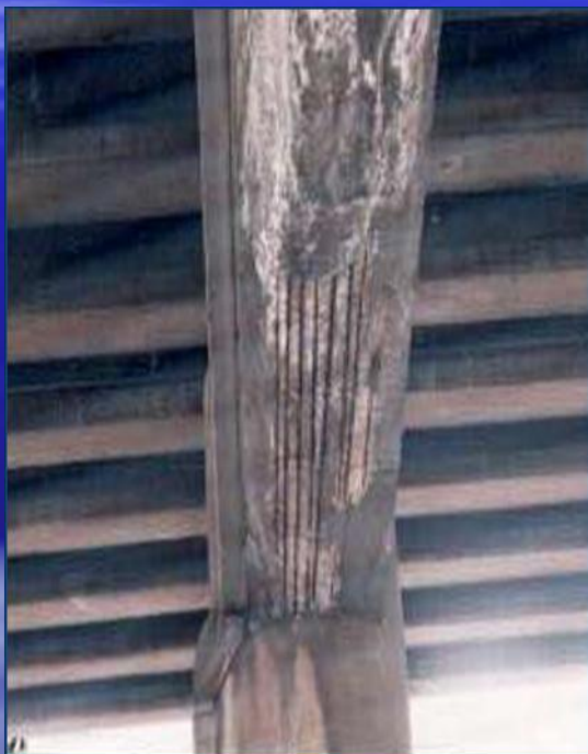
Перегрев бетона
