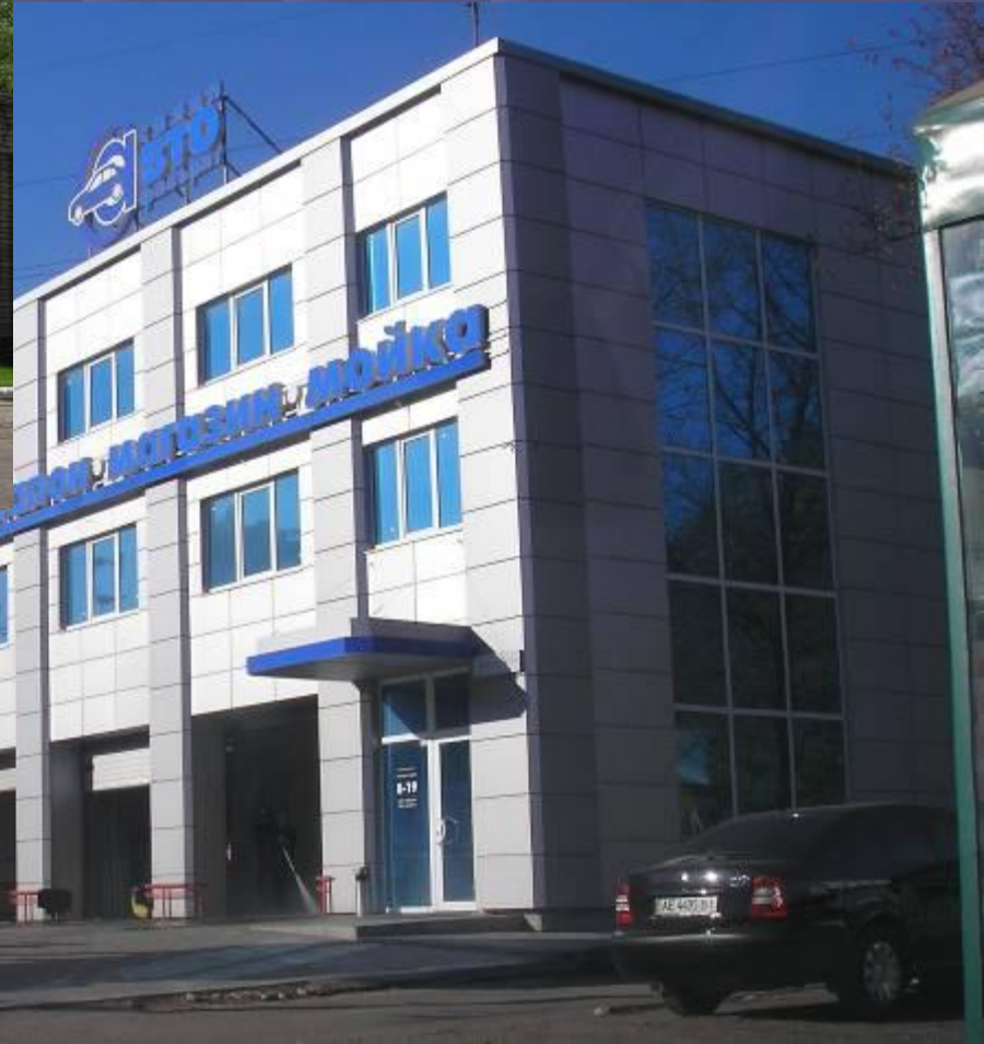
г. Днепропетровск, Автосалон VOLVO (облицовочные работы)
