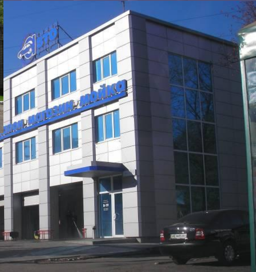
г. Днепропетровск, Автосалон VOLVO (облицовочные работы)
