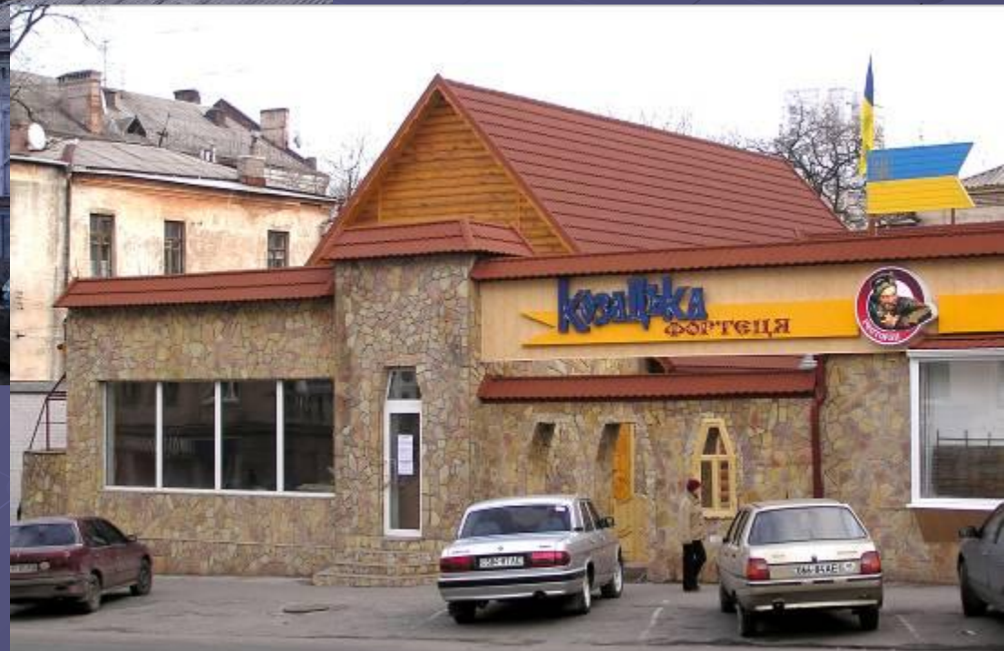
г. Днепропетровск, ул. Артема Мансардная надстройка III этажа (кровельные работы)
