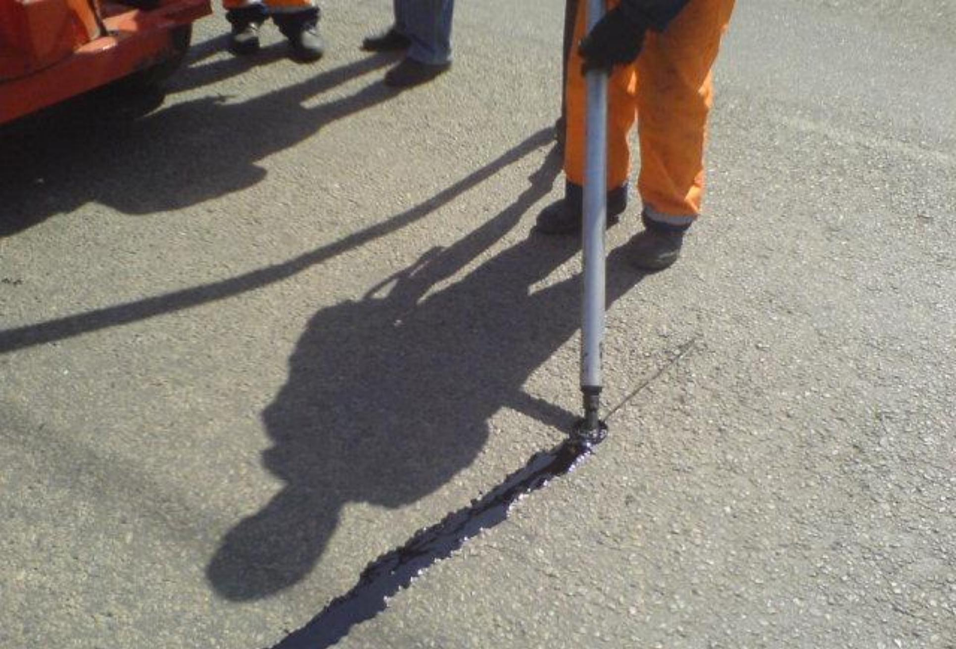
Заливка трещин в асфальтобетонном покрытии
