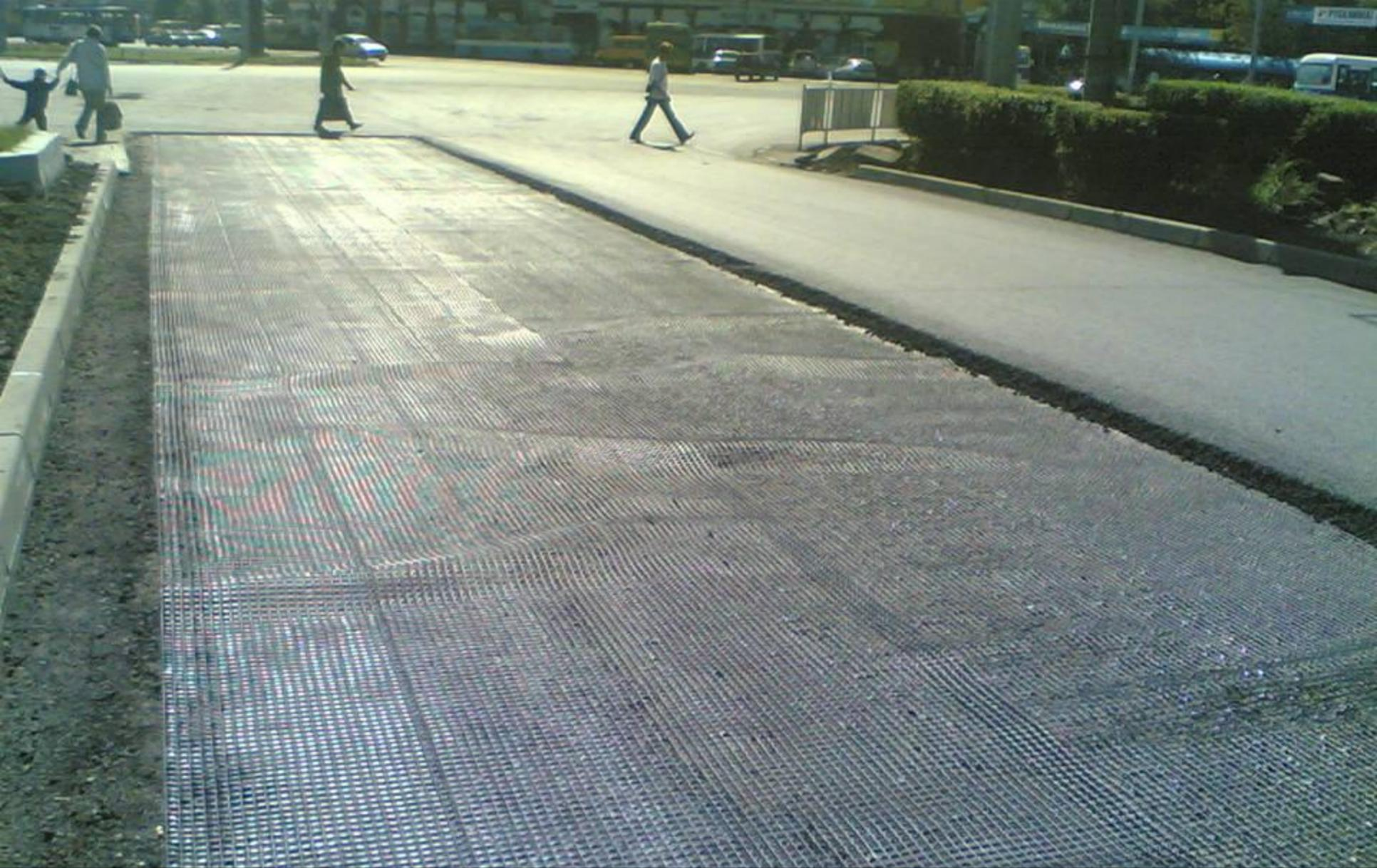
Устройство дорожного покрытия с применением геосинтетических материалов
