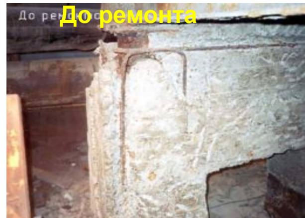
Фундаменты под флотомашины на фабрике СКРУ-3 Соликамск (2002г)
