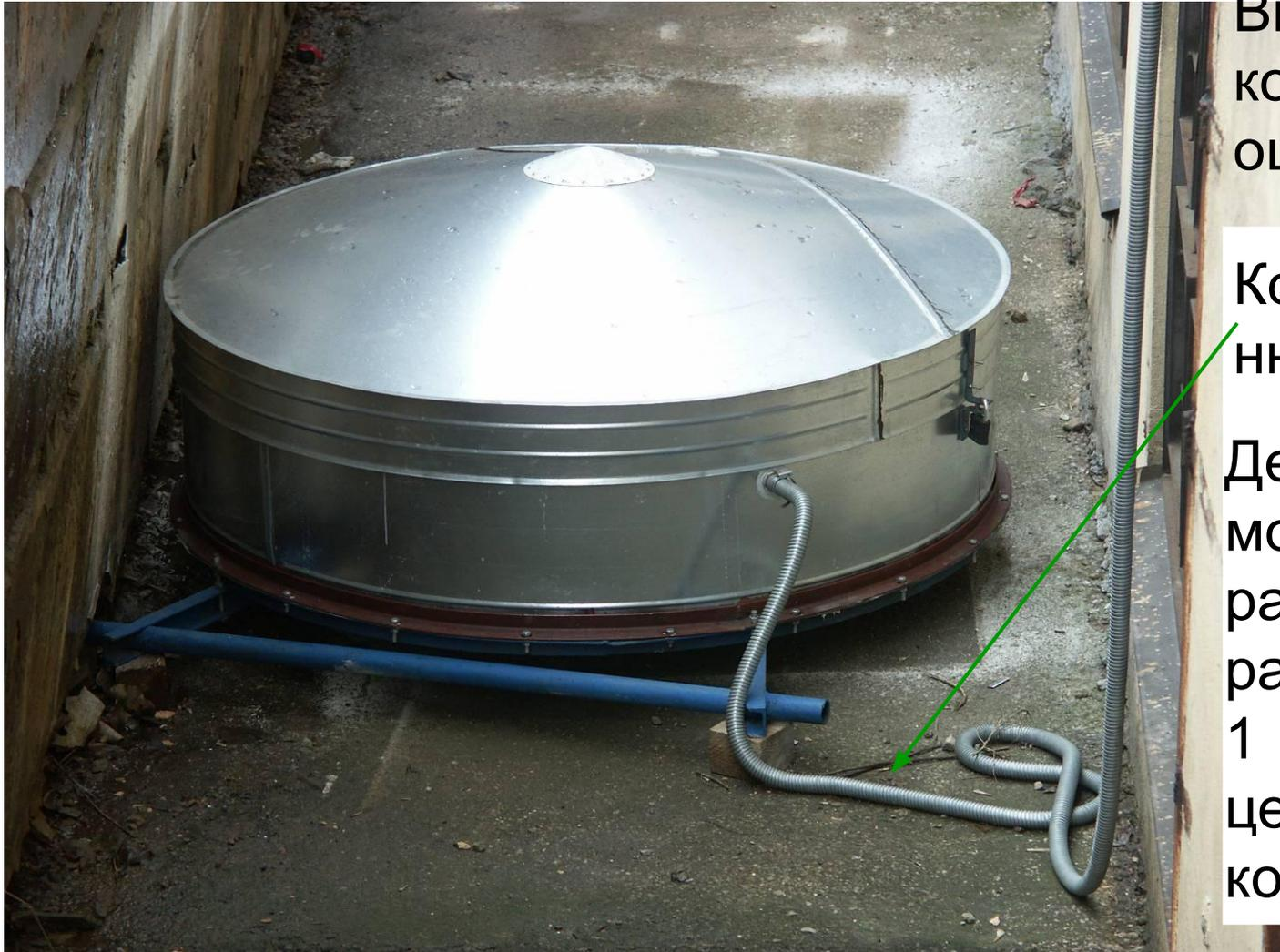
Внешний корпус – 0.7 мм оцинковка
