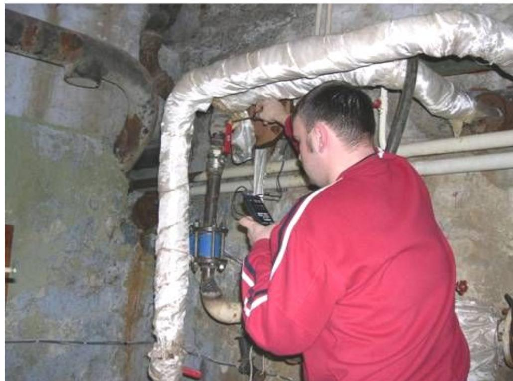
Теплоизоляция плохая. Разница температур обратного теплоносителя по стоякам около 30%. Система разбалансирована. Необходим ремонт теплоизоляции и балансировка. Посчитайте количество стояков! Какие работы предстоят при установке клапанов?
