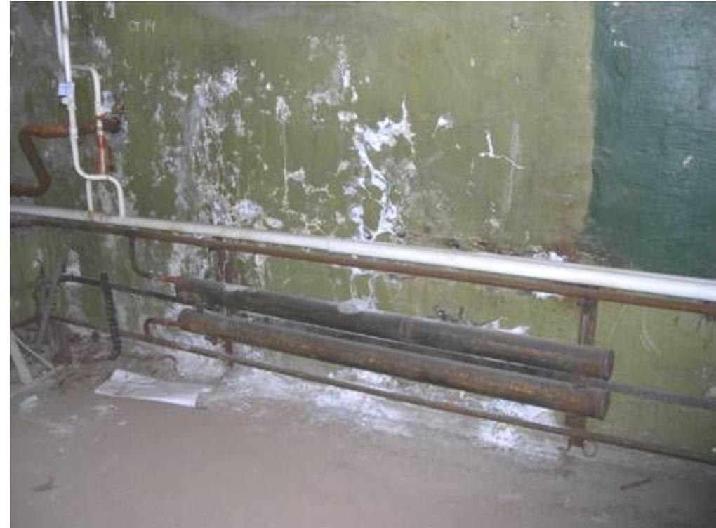
**Постоянных рабочих мест нет. Подвал отапливается. Теплоизоляция отсутствует. Утечек нет. Система отопления тупиковая с нижней разводкой. Балансировочных клапанов нет.**
