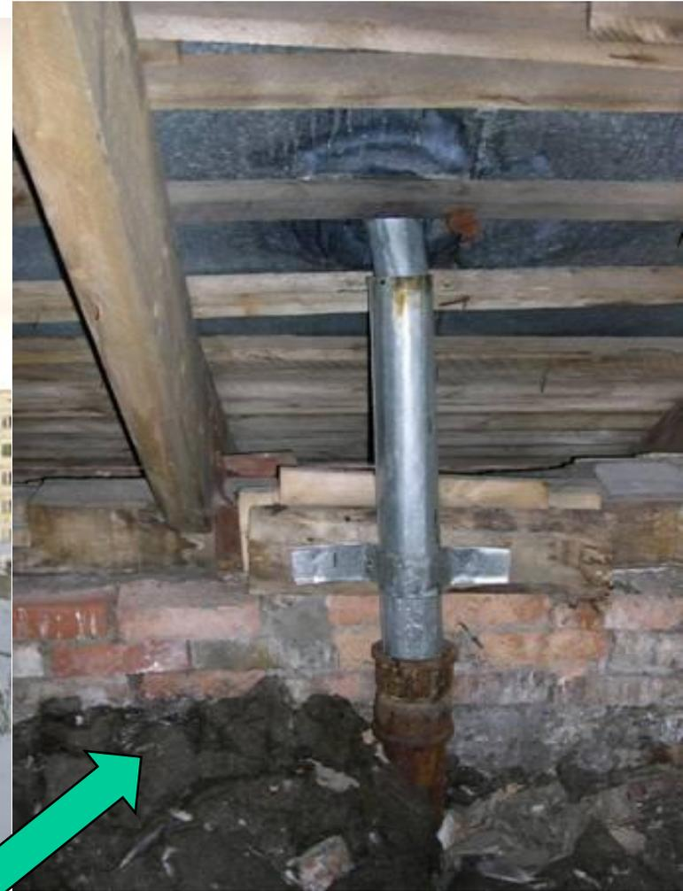
Многочисленные щели в кровле. Крыша течет. Теплоизоляция увлажняется и теряет свойства.
