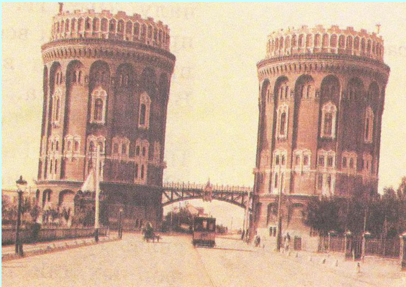
Московская водонапорная башня
