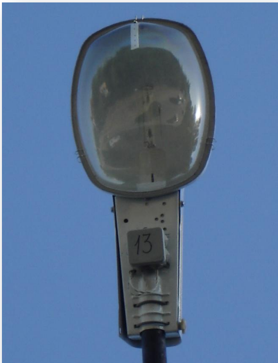
Светильник ЖКУ-150 «Пегас» с адресным управлением и внешним креплением приемника адресных команд.
