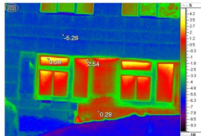
Нарушене теплоизоляции на торцевой стене здания
