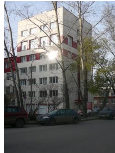
г. Томск, ул. Белинского, 53 Офисное здание
