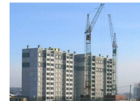
г. Златоуст, пр. Мира, д. 28 Жилой дом
