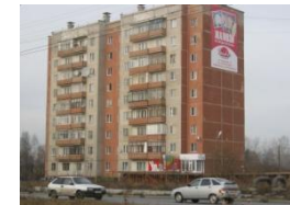
г. Златоуст, пр. Мира, д. 28 Жилой дом
