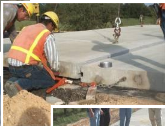
Установка железобетонной плиты в полотно дороги
