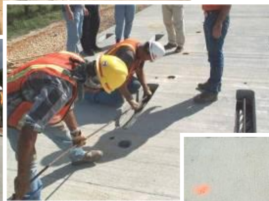
Подача стального каната в центр кармана напряжения
