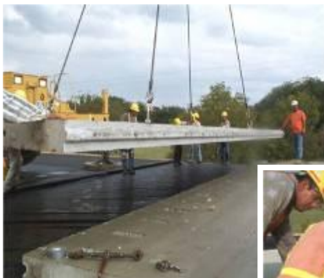
Подача бетонной плиты сборного типа на дорожное земельное полотно
