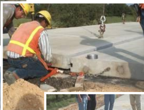
Установка железобетонной плиты в полотно дороги
