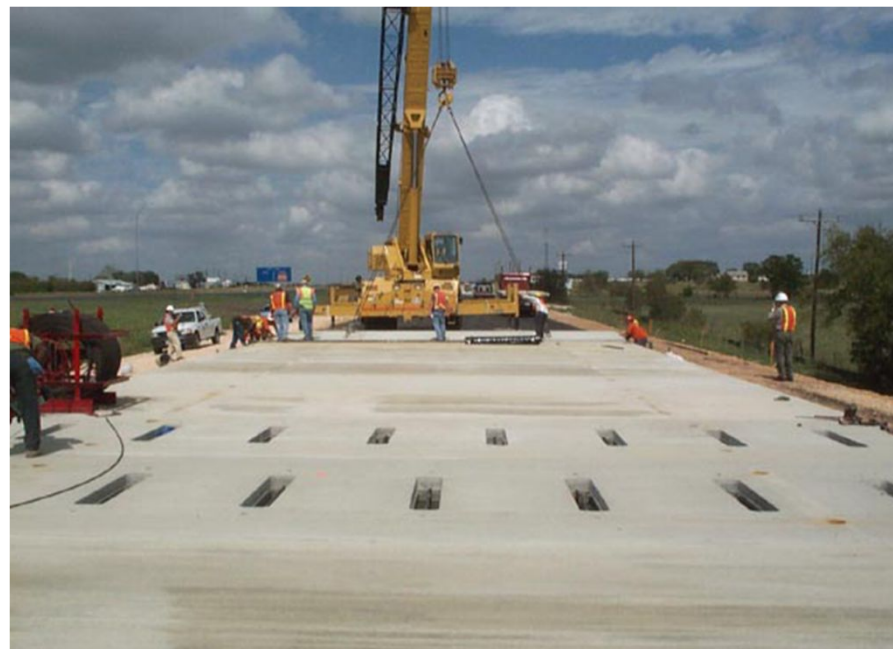
Рисунок 2. Трасса – IH-35 Frontage Road, США
