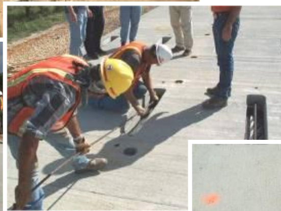
Подача стального каната в центр кармана напряжения
