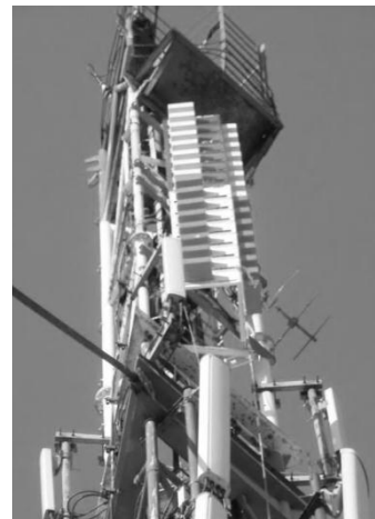
Замена аварийного оборудования
