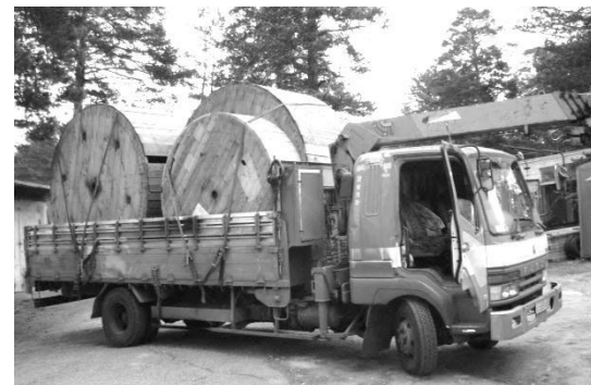
Перенос существующего оборудования для высвобождения частот под ЦТВ
