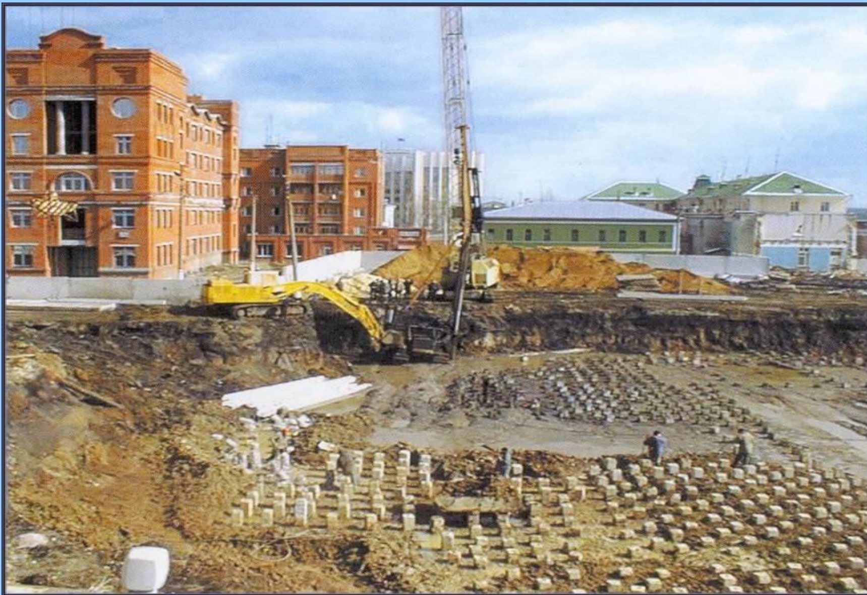
Фундамент будущего храма
