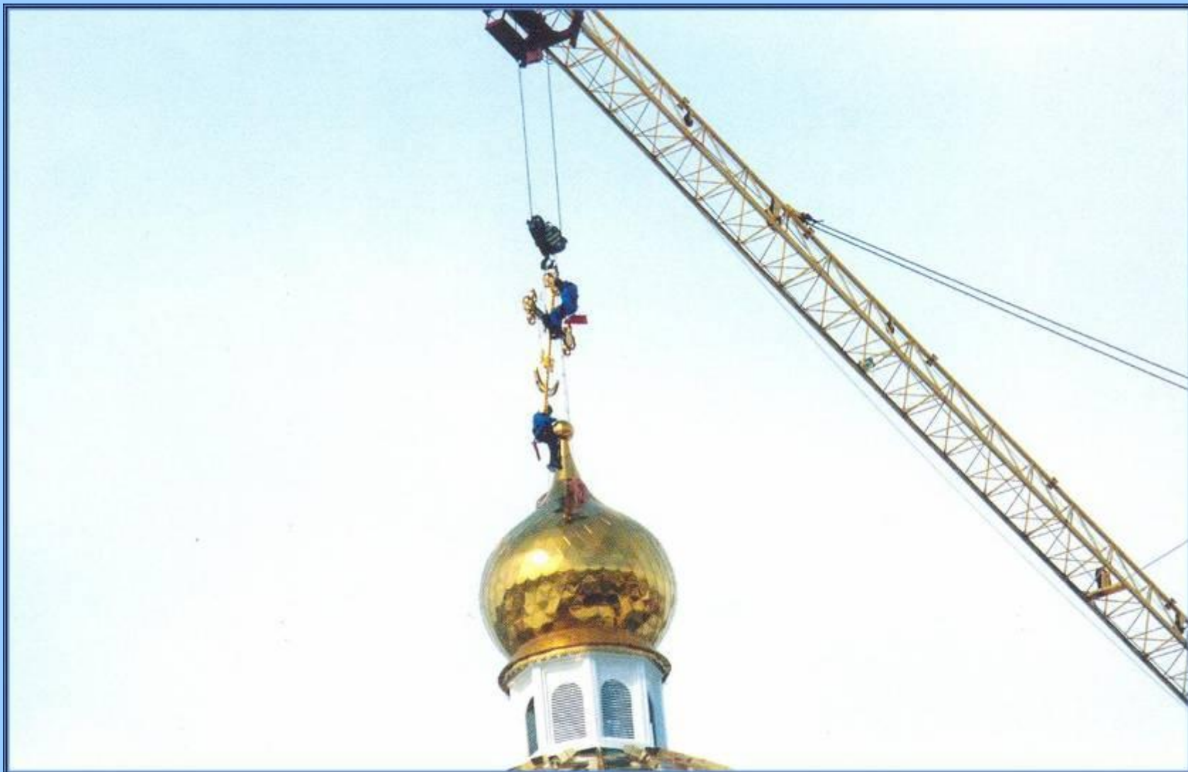
Монтаж креста главного купола
