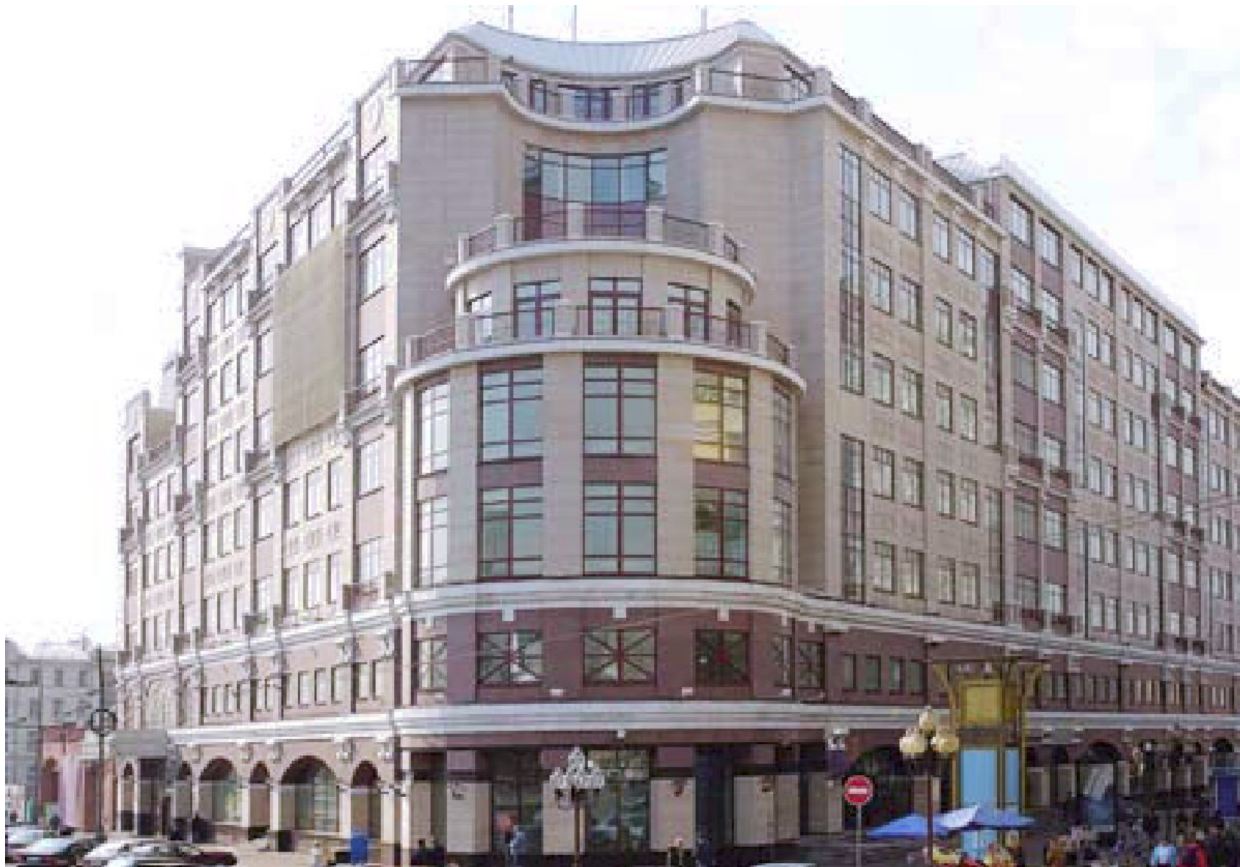
Офисное здание ТНК-ВР «Центр Альфа Арбат». Москва. Старый Арбат
