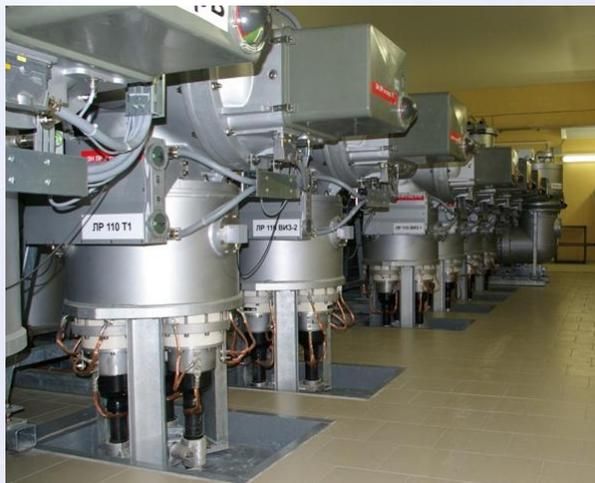
Комплектное распределительное устройство с элегазовой изоляцией. Смонтировано на ПС 110кВ «Берег», ПС 110кВ «Петрищевская»
