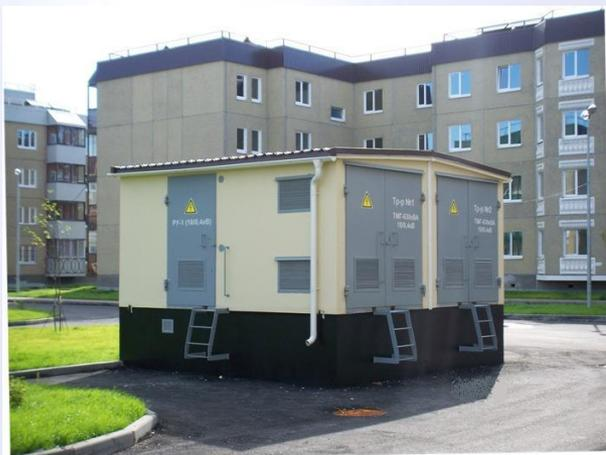
**Блочные комплектные одно- и двухтрансформаторные подстанции** - (БКТП), мощностью от 250 до 1500 кВА блочного исполнения (в железобетонном корпусе), предназначены для приема, преобразования и распределения электроэнергии и снабжения ею городских жилищно-коммунальных, общественных и промышленных объектов, населённых пунктов, зон индивидуальной застройки и коттеджных поселков.
