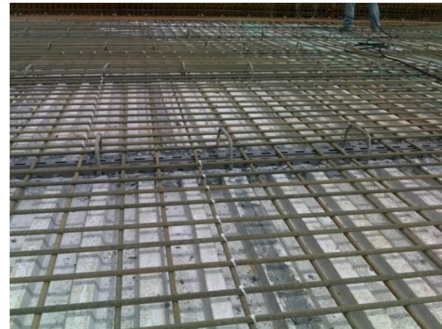
Стержни в настиле нового моста в Co. Fermanagh, Северная Ирландия
