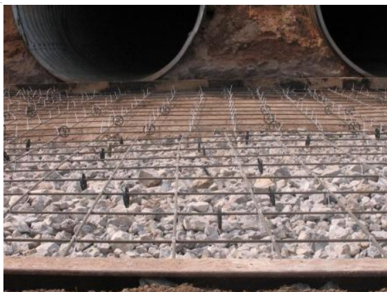
Сетка из композитных стержней, закладка на опытном участке
