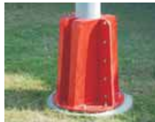
Фланцевая опора
