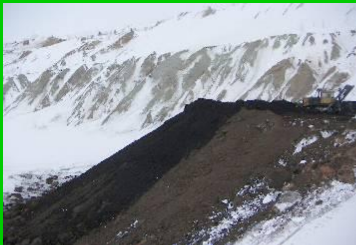
Подсыпка бортов южного склона
