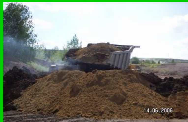
Подсыпка бортов южного склона
