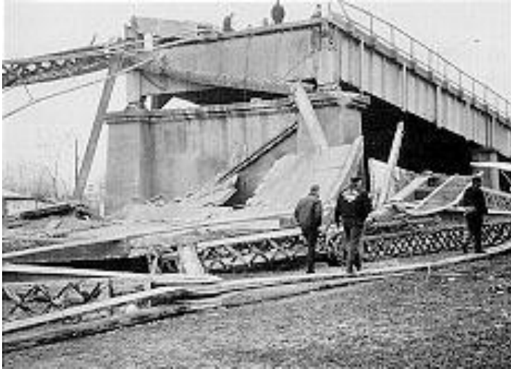
Silver Bridge, США, 1967 год, разрушение в результате коррозии. Мост рухнул в менее чем за минуту, убив 46 человек
