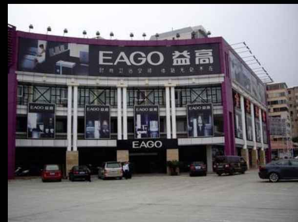
рис. 1 Фасад здания фабрики
