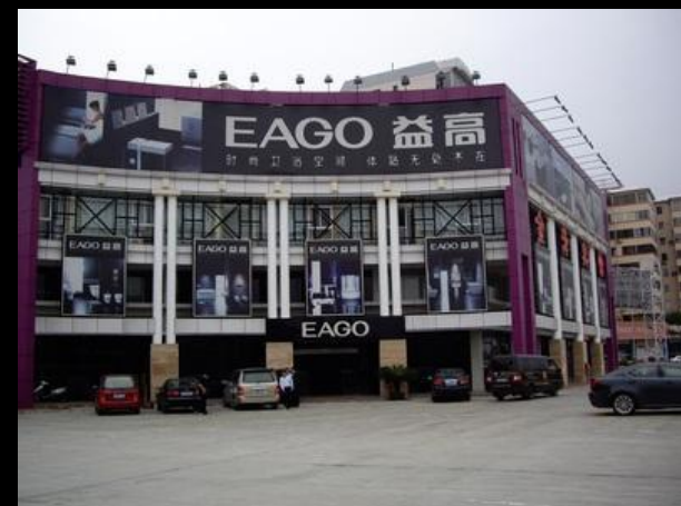
рис. 1 Фасад здания фабрики
