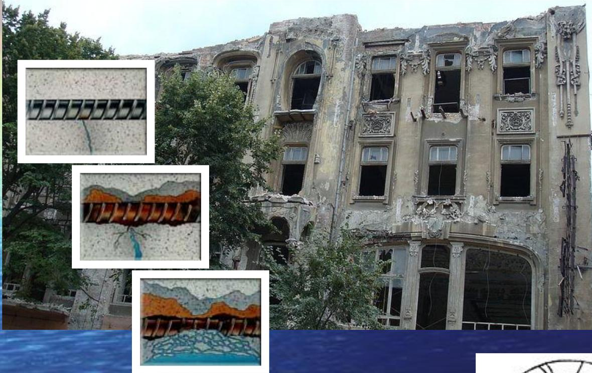
Внешние воздействия – агрессивные среды, грунтовые и сточные воды, загрязненная атмосфера – приводят к одному и тому же печальному итогу: бетонные и железобетонные конструкции начинают медленно разрушаться.
