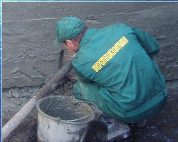
**MORTAR®** - цементная водостойкая укрепляющая строительная сухая смесь, применяемая для гидроизоляции стыков, примыканий, швов и трещин, имеющих в бетонных конструкциях.
