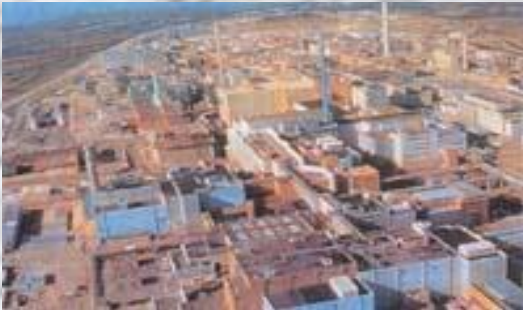
Рис.2. Предприятие по переработке ОЯТ фирмы SOGEMA близ Шербурга (Франция).
