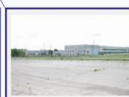
Станция очистки воды
