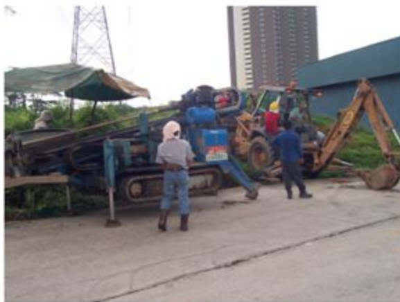
Эксковатор (земляные работы)
