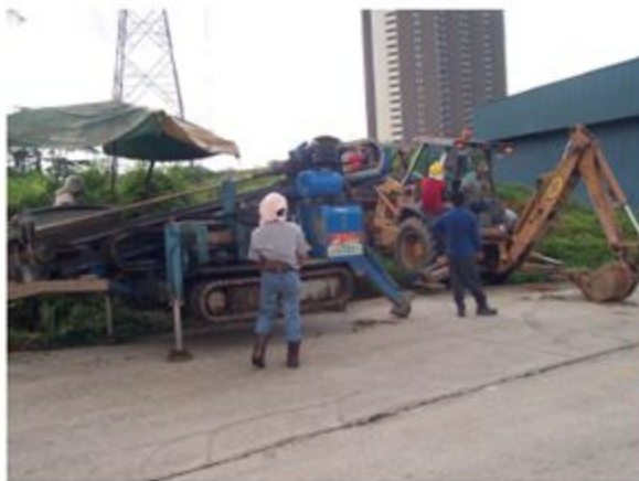
Эксковатор (земляные работы)
