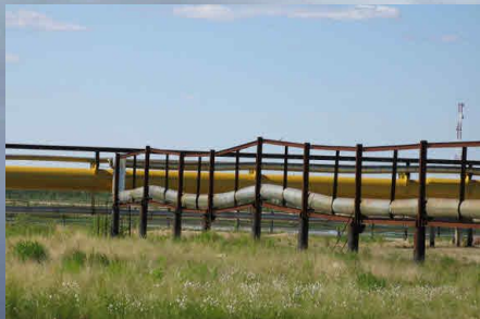
Деформации опор при развитии морозного пучения
