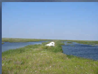
Формирование термокарстовых полос вдоль подземных газопроводов
