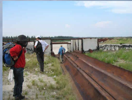
Устройство водопропускной системы при борьбе с оврагообразованием
