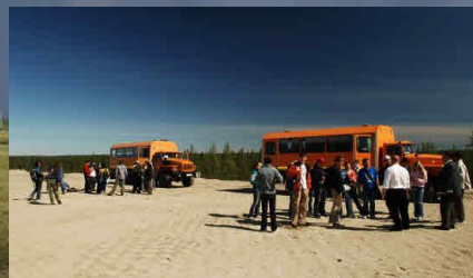
Песчаная подсыпка под строящийся куст скважин
