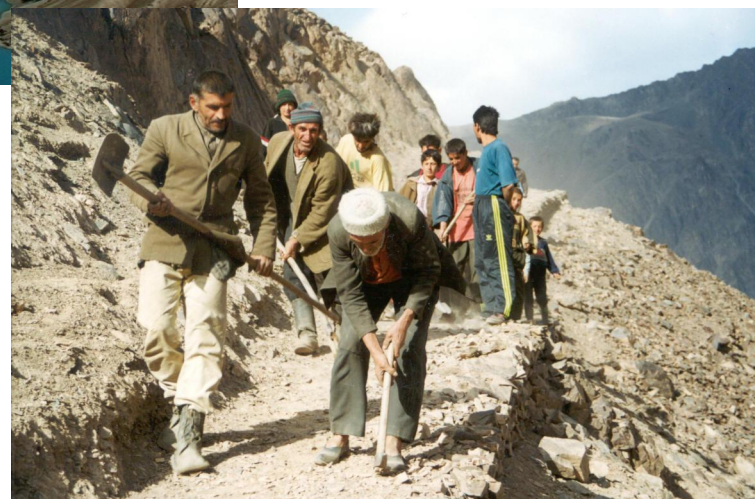
Работы на маршрутах эвакуации
