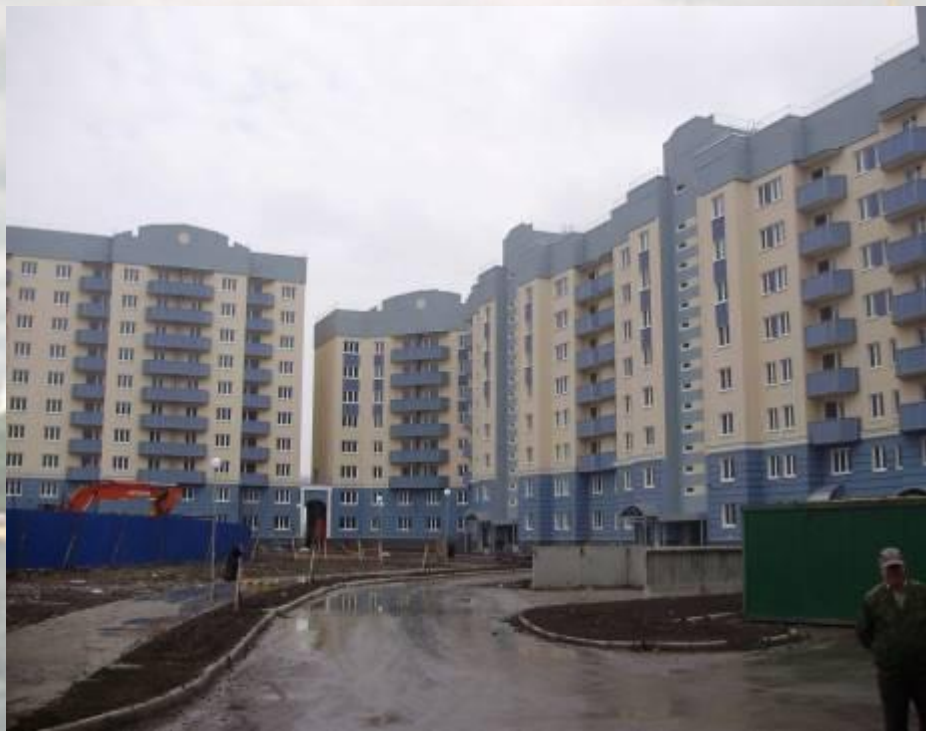
УЛ. МАРШАЛА ЗАХАРОВА
