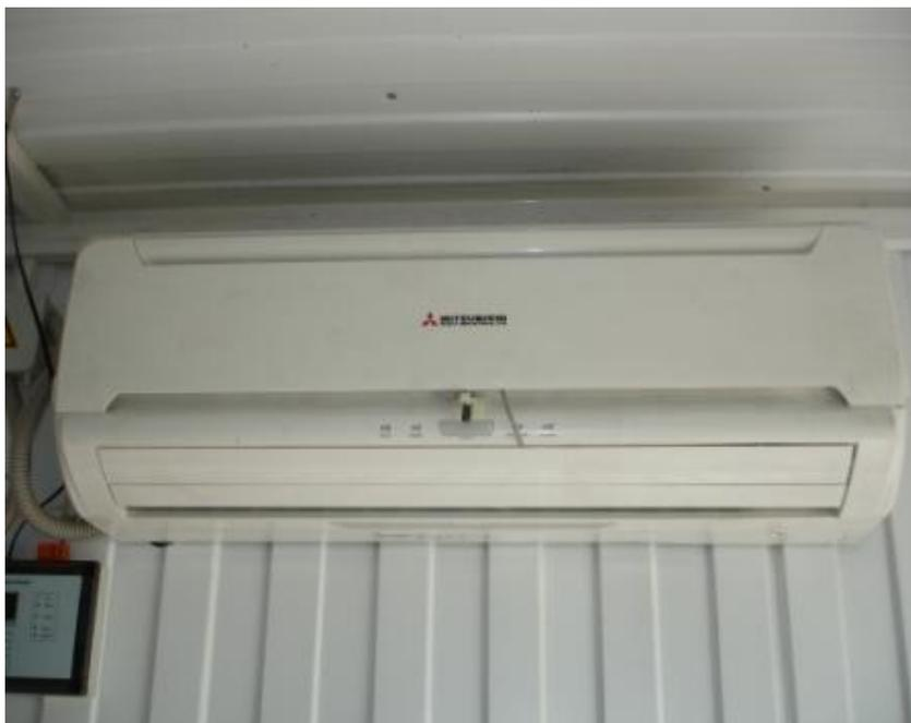
**Внутренние блоки подключаются через программируемый модуль согласования. Модуль согласования позволяет запрограммировать поочередную работу кондиционеров: включение и выключение кондиционеров по времени, работа в параллель.**
