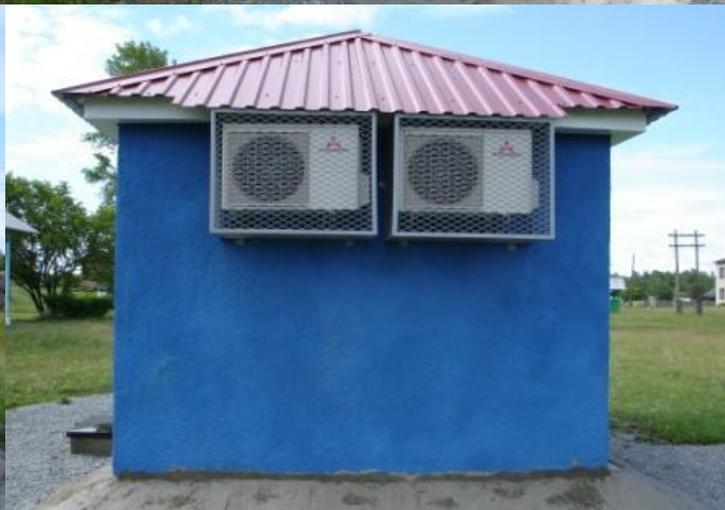
**БКАЭС состоит из 2-х помещений- связевого и агрегатное, разделенных между собой противопожарной перегородкой.**
