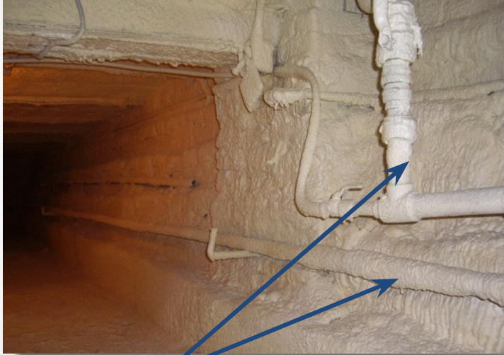
Теплоизоляция трубопроводов и стен Заводоуправление
