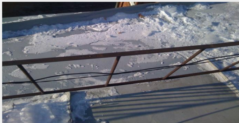
Нанесение органосиликатной композиции при T -13 C
