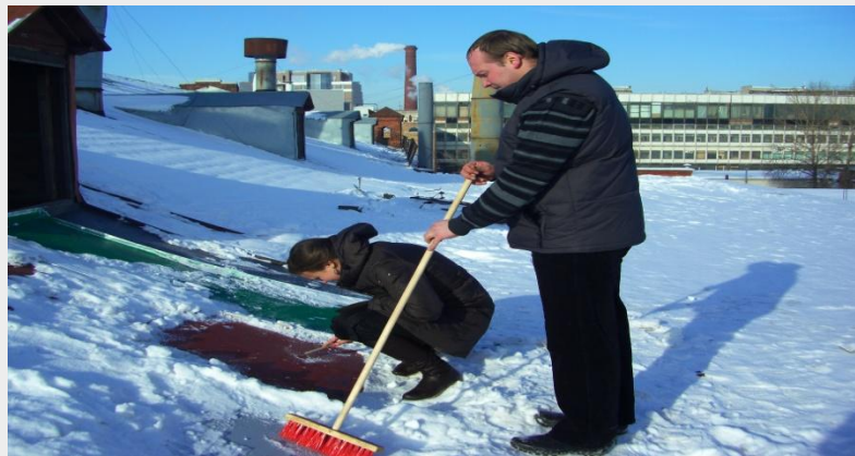
Нанесение органосиликатной композиции при T -13 C
