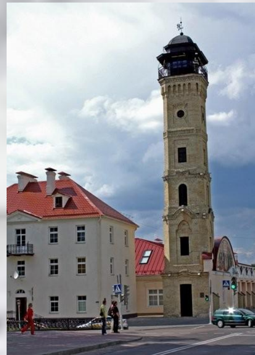
Башня пожарного депо
