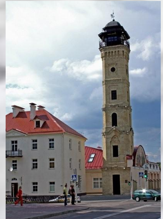
Башня пожарного депо
