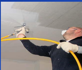
ОКРАСКА ПОТОЛКА СПЕЦИАЛЬНЫМИ СИЛИКАТНЫМИ КРАСКАМИ
