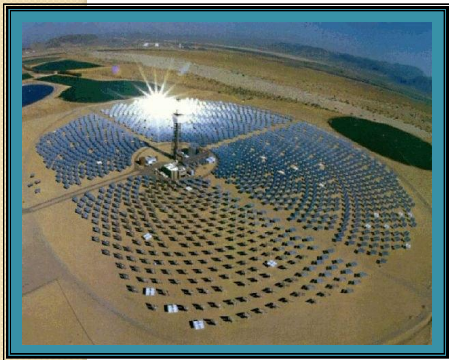
Солнечная электростанция (СЭС)
