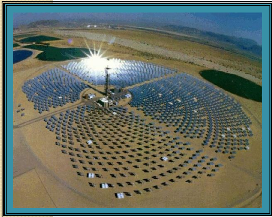
Солнечная электростанция (СЭС)
