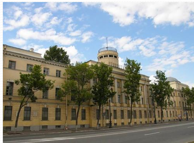
Здание Морского кадетского корпуса
