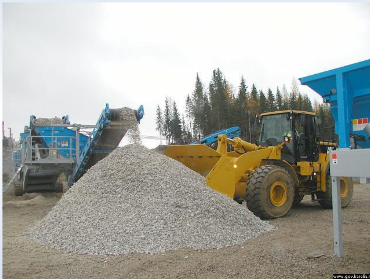
Медвежьегорский район. Передвижной щебеночный завод
