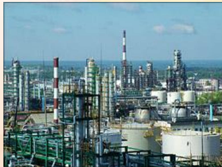
ОАО "Славнефть-Ярославнефтеоргсинтез" и Ярославский нефтеперерабатывающий завод им.Д.И.Менделеева
