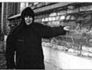
А.В. Карелин проверяет ход работ по ремонту в подвале многоквартирного дома.
