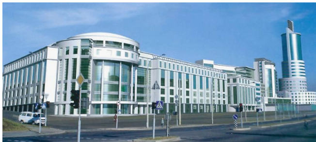
2010 Новое здание Головного офиса ОАО «АСБ Беларусбанк» (ведется строительство)
