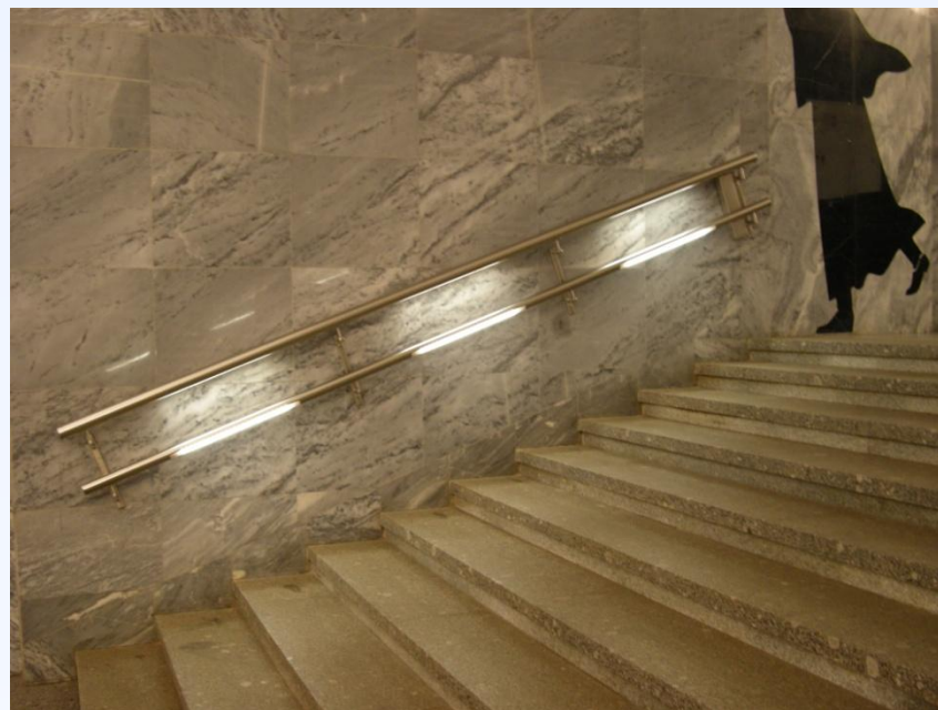
б) пример размещения светильников в перилах лестницы
