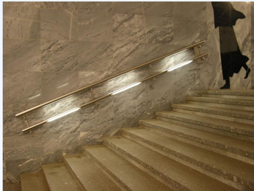
б) пример размещения светильников в перилах лестницы
