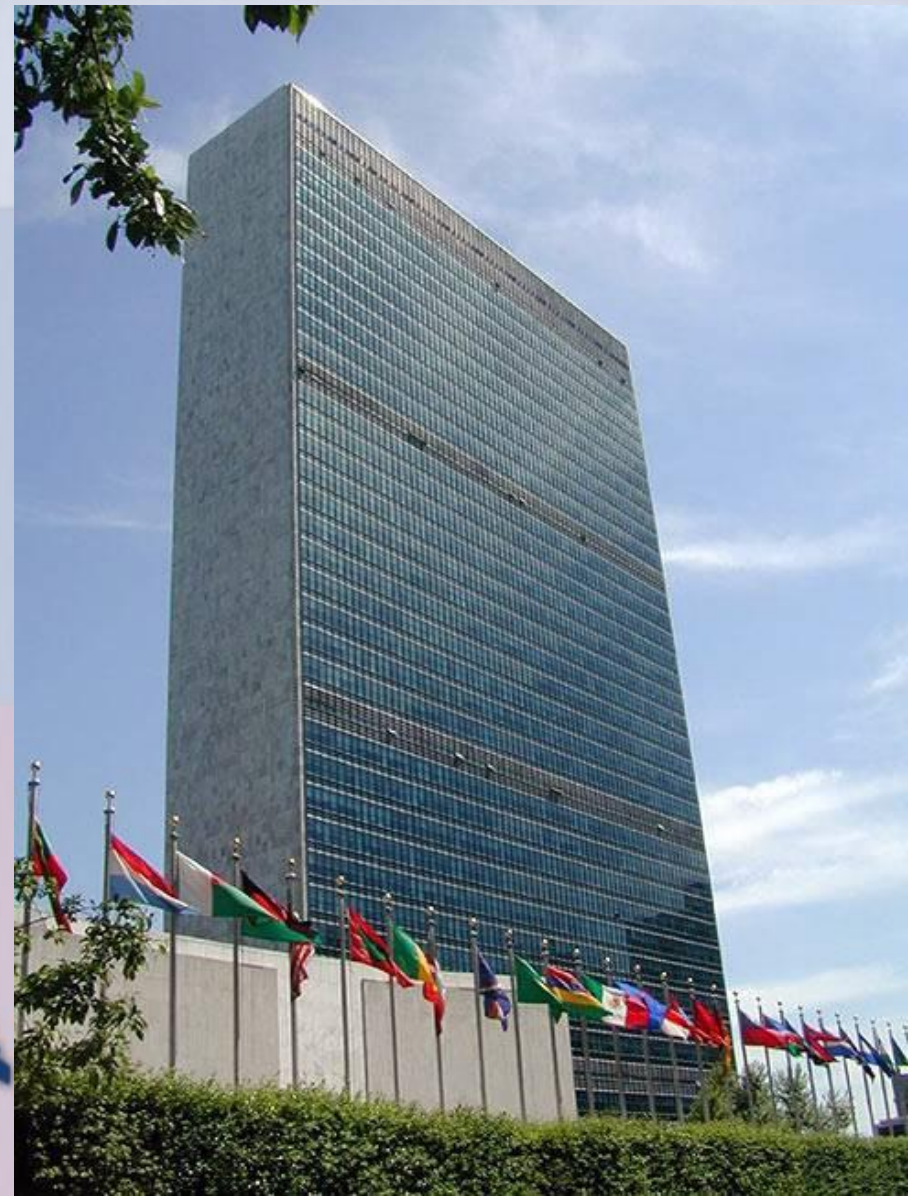
Здание штаб-квартиры ООН в Нью-Йорке (США).
