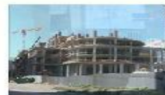
Строительство здания Управления Минюста
