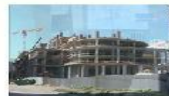
Строительство здания Управления Минюста
