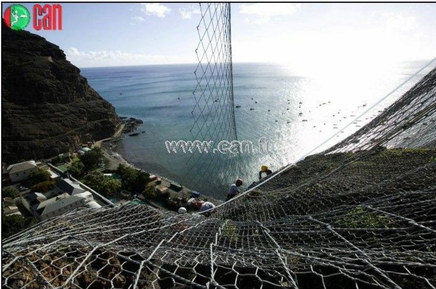
**Стальные заградительные сети**, с кольцевыми ячейками, предназначены для укрепления откосов насыпей и выемок, косогоров, берегов пересекаемых водотоков, оврагов и логов, водоотводных, регуляционных и других дорожно-мостовых сооружений. Встретить такого рода конструкции можно повсеместно практически во всех горных странах.
