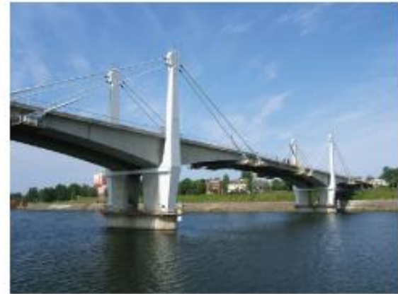
Мост в г.Кимры, реконструированный с использованием наномодифицированных легких бетонов
