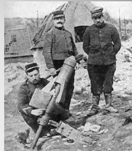
На западном фронте. Поступление союзников на реку Сомма. Захваченные у немцев традиционные деревянные минометы, стянутые стальной проволокой.
