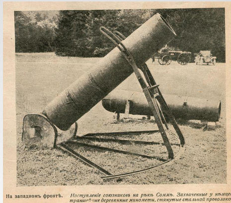
На западном фронте. Поступление союзников на реку Сомма. Захваченные у немцев традиционные деревянные минометы, стянутые стальной проволокой.
