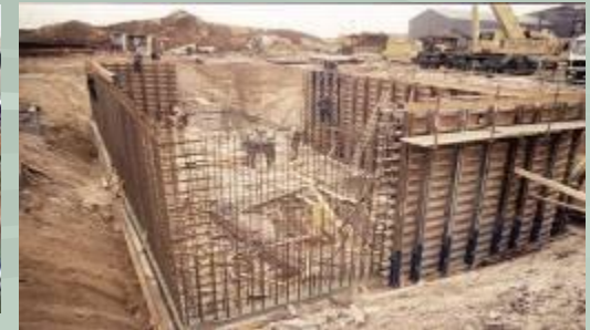
Опалубка из OSB при монолитном строительстве
