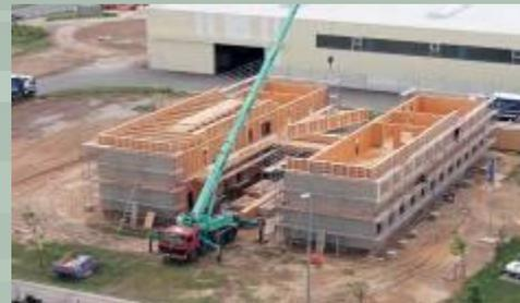
Опалубка из OSB при монолитном строительстве
