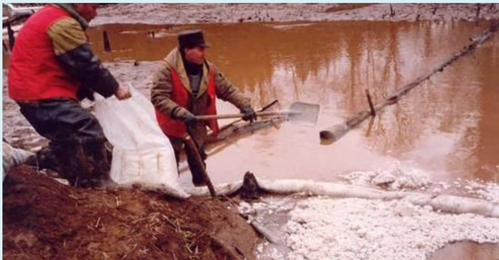
Использование боновых заграждений и сорбционных материалов для улавливания нефтепродуктов
