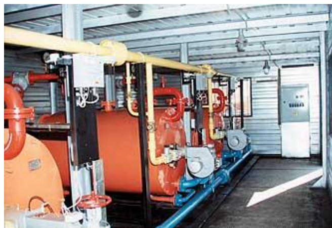
Установка котельная блочная
